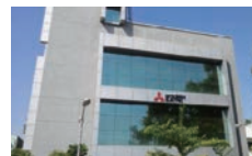
Pune/Gurgaon/Bangalore/ Chennai/Ahmadabad, India 인도 FA센터
